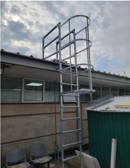
Instalación de gateras para protección de los cielos
