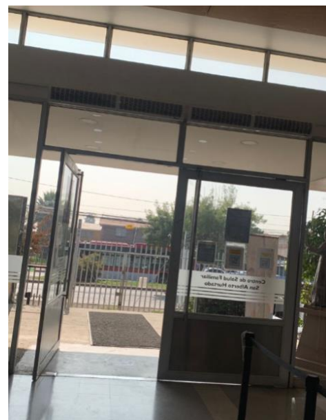
Instalación de cortinas de aire en la entrada principal
