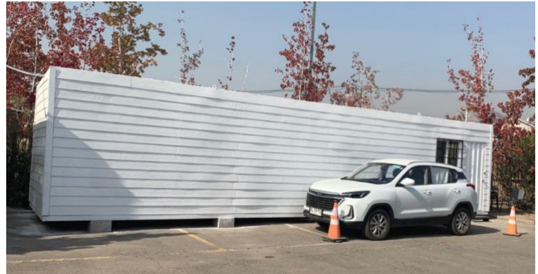
Compra e instalación de bodega
